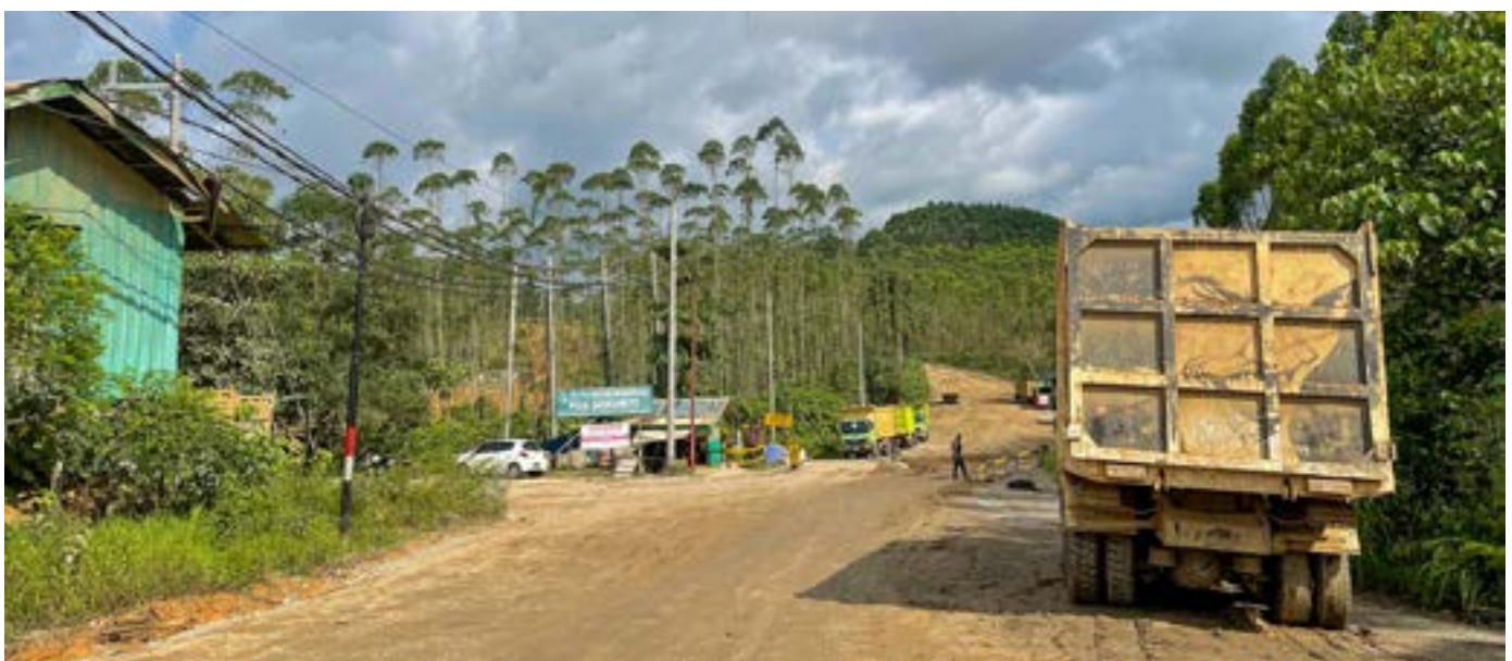
Wo die künftige indonesische Hauptstadt entstehen soll, prägen Bauarbeiten zurzeit das Bild im Verwaltungsbezirk Penajam Paser Utara (Ost-Kalimantan/Borneo) – hier beim Dorf Bumi Harapan im April 2023. Das hügelige Areal ist noch zum großen Teil mit Eukalyptus-Plantagen bewachsen. Bildquelle: Hayyu Mahabbah
